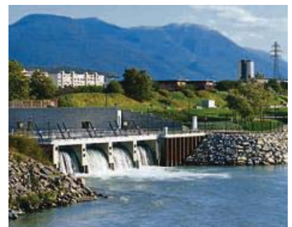
Située dans l'agglomération grenobloise, la centrale du Rondeau réutilise l'eau du barrage de Saut du Moine. Photo EDF
